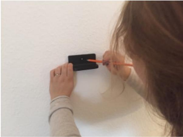
Zum Anbohren müssen die Teile des Wandhalters an die Wand gehalten werden. Idealerweise zeichnet man zu zweit an. Trotz Wasserwaage und Maßstab zeichneten wir die beiden Reifenhalter auf verschiedenen Höhen an - Für die Stabilität nicht wirklich von Relevanz. Dennoch ist der optische Effekt so eher unschön, zumal die Reifen nun direkt an der Wand anliegen. Die Folgen sind schlieren und Dreck an der Raufasertapekte.
