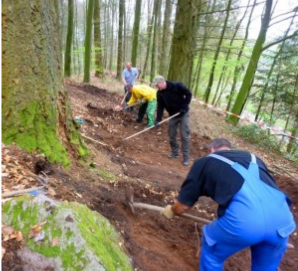
Streckenarbeiten in Bad Säckingen
